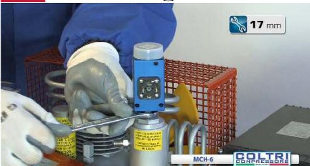
Avvitare il pressostato sul tappo superiore forato
